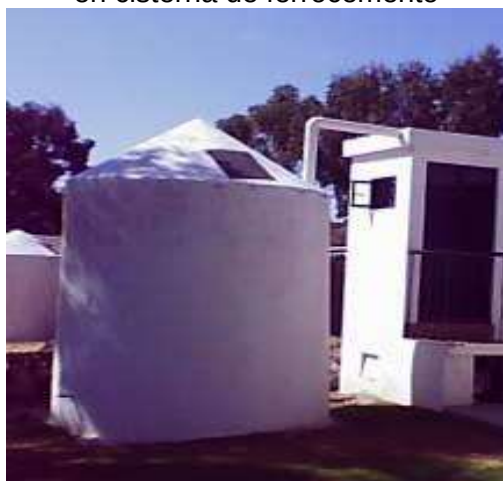
Figura 9. Captación de agua de lluvia de la azotea en cisterna de ferrocemento
