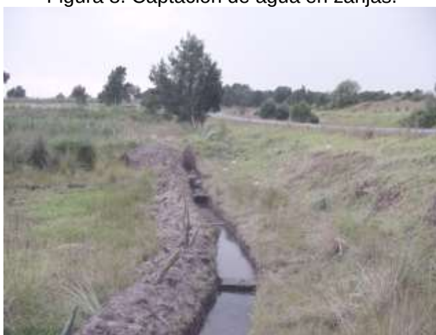
Figura 8. Captación de agua en zanjas.
