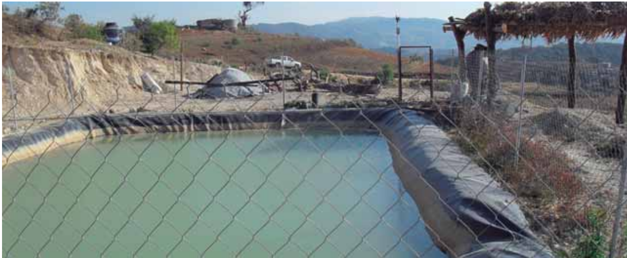
Figura 4.10. Olla para captación y almacenamiento de agua de lluvia en San Miguel Huautla, Oaxaca. Foto: Sánchez, 2014.
