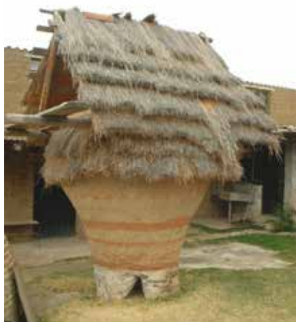
Figura 9.2 Cuexcomate construido en instalaciones del GVG para resguardar parte de los fondos de semillas nativas (Fuente: Archivo GVG).
